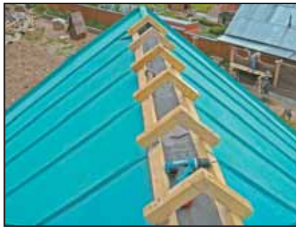
Монтаж каркаса вентилируемого конька. Гидроизоляция будет прорезана непосредственно перед креплением водостойкой фанеры 16 мм.
