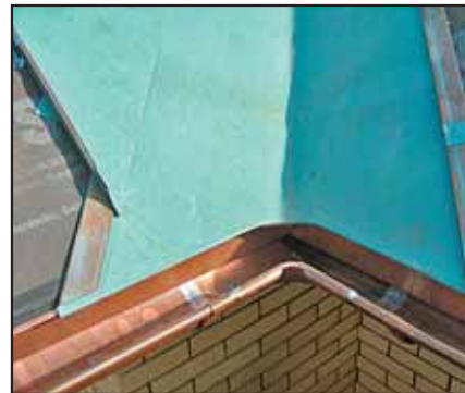
Узел сопряжения ендовы и фартука водосточного жёлоба.
