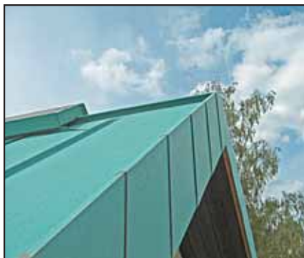
Обшивка ветровой доски, выполненной вертикальными швами «в зацеп» с помощью гибочных станков.
