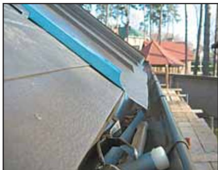
Вид сопряжения кровельных картин и фартука водосточной системы. Кровли из металлов с полимерным покрытием необходимо монтировать, применяя специальный молоток с пластиковым наконечником.
