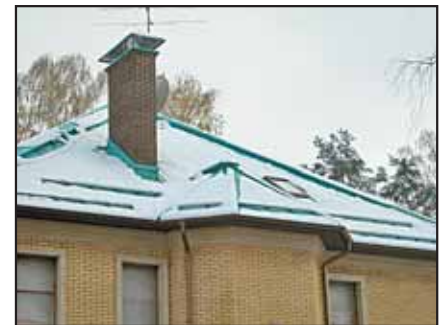
Зимой два ряда снегозадержателей предотвращают резкий сход подтаявшего снега и более равномерно распределяют нагрузку на фальцы, к которым крепятся кронштейны снегозадержателей.
