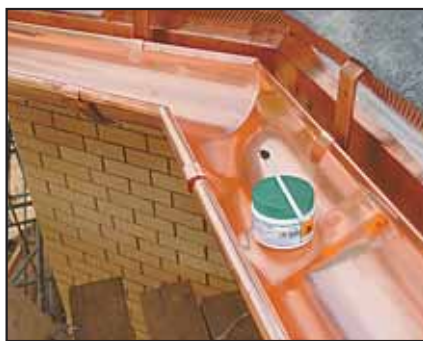
Внутренний нестандартный угол водосточного жёлоба, подготовленный к пропайке шва.
