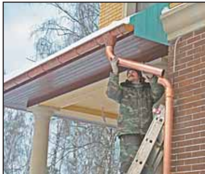
Подгонка и монтаж водосточных труб из классической меди КМЕ.
