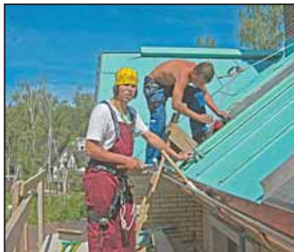
Монтаж кровельных картин с учётом температурного расширения меди. При сопряжении с фартуком зазор составляет 10 мм.
