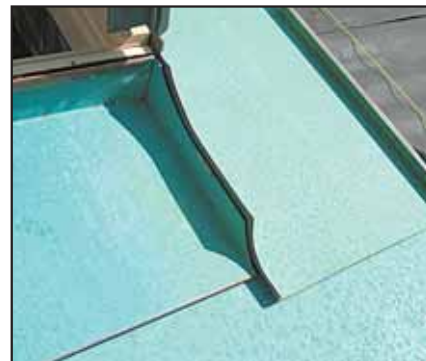
Подгонка элементов обводки мансардного окна без окладов.
