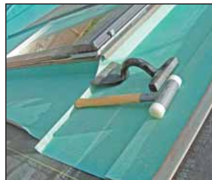
Молоток с пластиковым наконечником и малая оправка-лопатка позволяют квалифицированному жестянщику качественно выполнить вручную любой узел.
