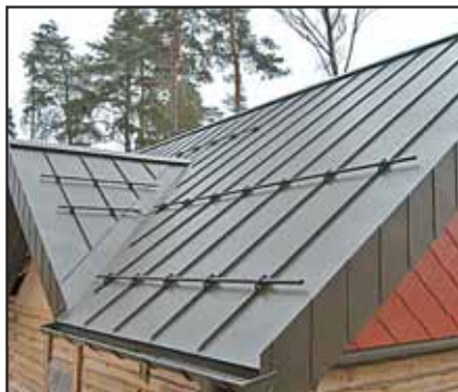
Фальцевая кровля из алюминия ПРЕФА. Объёмные коньки и ветровые планки фронтона выполнены на гибочных станках непосредственно на стройплощадке.
