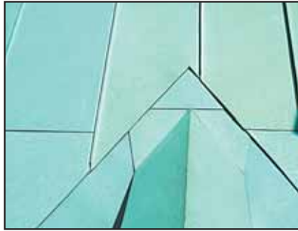
Готовый узел врезки вентилируемого конька в основную кровлю.
