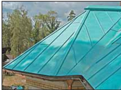
Готовая кровля эркера с горизонтальным вентилируемым коньком и объёмными невентилируемыми коньками между гранями ската.
