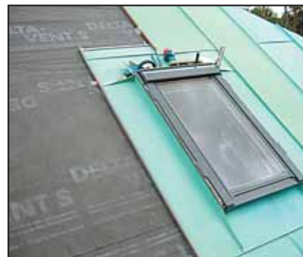
Монтаж мансардного окна без оклада техникой двойного фальца.
