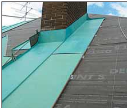
Подгонка деталей воротника каминной трубы.
