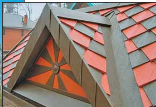
Выпускная работа учеников школы «Саврос» — навес из двухцветного алюминия ПРЕФА над входной калиткой усадьбы в Мещерино, Подмосковье.
