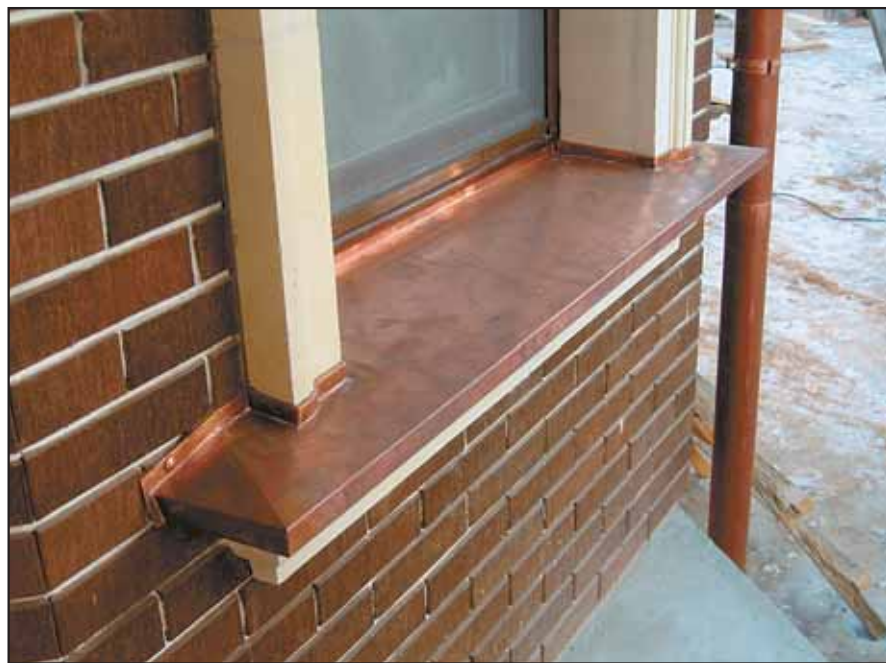
Элемент декоративного оконного отлива из меди КМЕ. Защита деталей фасадов — неотъемлемая часть обучения кровельщиков.
