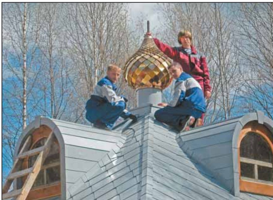
Монтаж купола на крыше часовни у Истока Волги.
