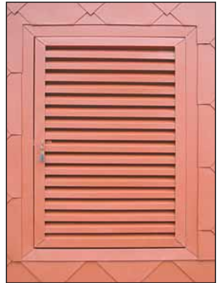
Дверь фронтона жалюзийного типа из алюминия ПРЕФА, которую изготовил Женя.
