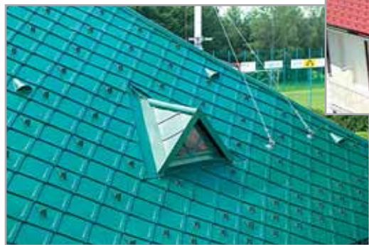
Кровли из штучных материалов из алюминия с полимерным покрытием австрийской компании ПРЕ-ФА (ромбы, гонт, черепица).
