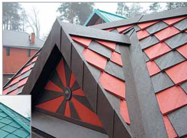
Кровли из объёмных ромбов, выполненных на гибочном станке, который разработан в Академии кровельного мастерства.
