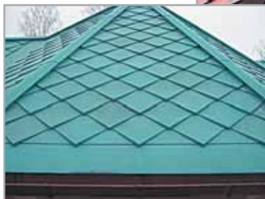
Кровли из объёмных ромбов, выполненных на гибочном станке, который разработан в Академии кровельного мастерства.
