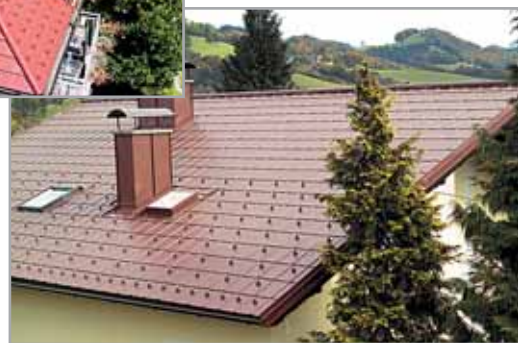
Кровли из штучных материалов из алюминия с полимерным покрытием австрийской компании ПРЕ-ФА (ромбы, гонт, черепица).
