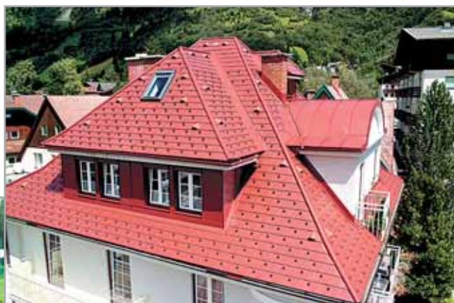
Кровли из штучных материалов из алюминия с полимерным покрытием австрийской компании ПРЕ-ФА (ромбы, гонт, черепица).
